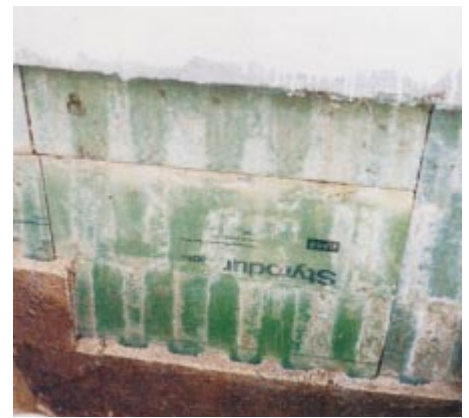
Abb. 2: Perimeterdämmung des Objektes 2 mit außenseitiger Polystyrol-Dränplattenschicht, die mit teller- großen Klebeflächen an der Dämmschicht befestigt ist.
