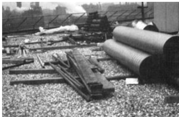
Bild 2: Flachdachbaustelle mit Baumaterialien
