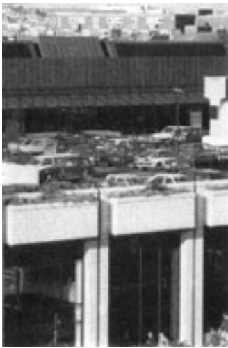
Bild 10: Nutzung der Dachfläche als Parkdach. Wärmedämmung nach der Umkehrdachkonstruktion mit Styrodur® unter aufgestellten Betonplatten
