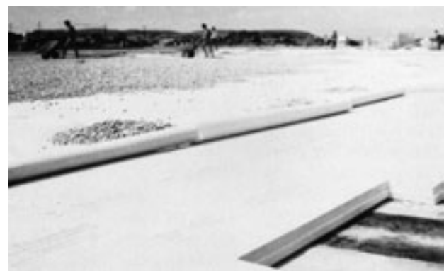
Bild 4: Energetische Sanierung eines Warmdaches durch ein Plusdach
