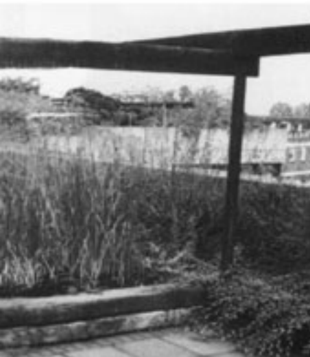
Bild 11: Teilweise begrünte Dachterrasse, die mit Styrodur® nach dem Umkehrdachprinzip ausgeführt wurde
