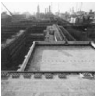
Bild 7: Mit Styrodur® LDE wärmegeämmtes Flachdach. Im Randbereich sind zur Windsogsicherung zusätzlich Rasengittersteine aufgelegt
