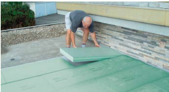
Bild 6a, b: Leichte, schnelle und wetterunabhängige Verarbeitung von Styrodur® C
