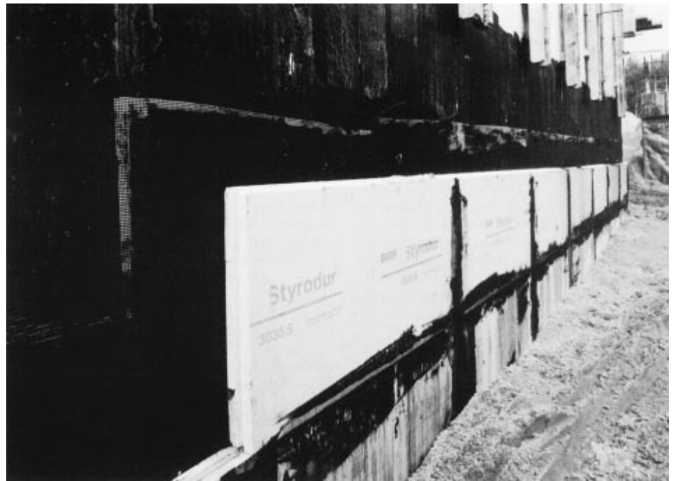
Bild 13: Perimeterdämmung im Grundwasserbereich: Die Platten werden vollflächig verklebt.
