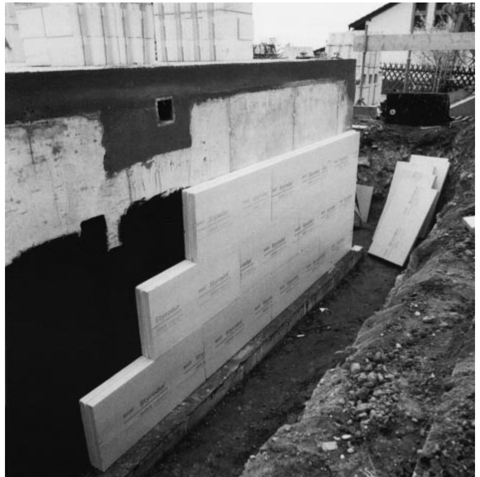
Bild 7 (unten): Verlegung der XPS-Perimeterdämmplatten mit versetzten Fugen.
